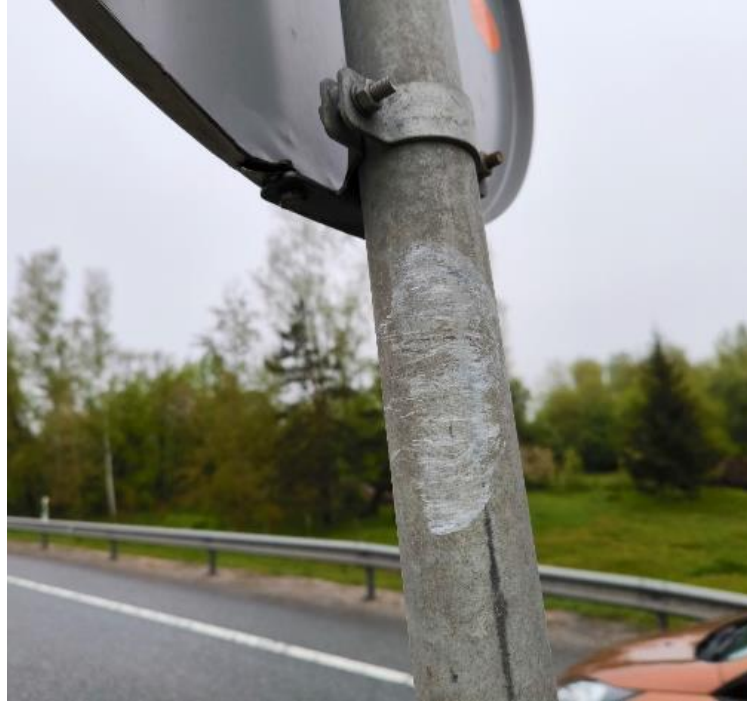
Att. 5. Bojātā ceļazīme šosejas A1 sadales līnijā
