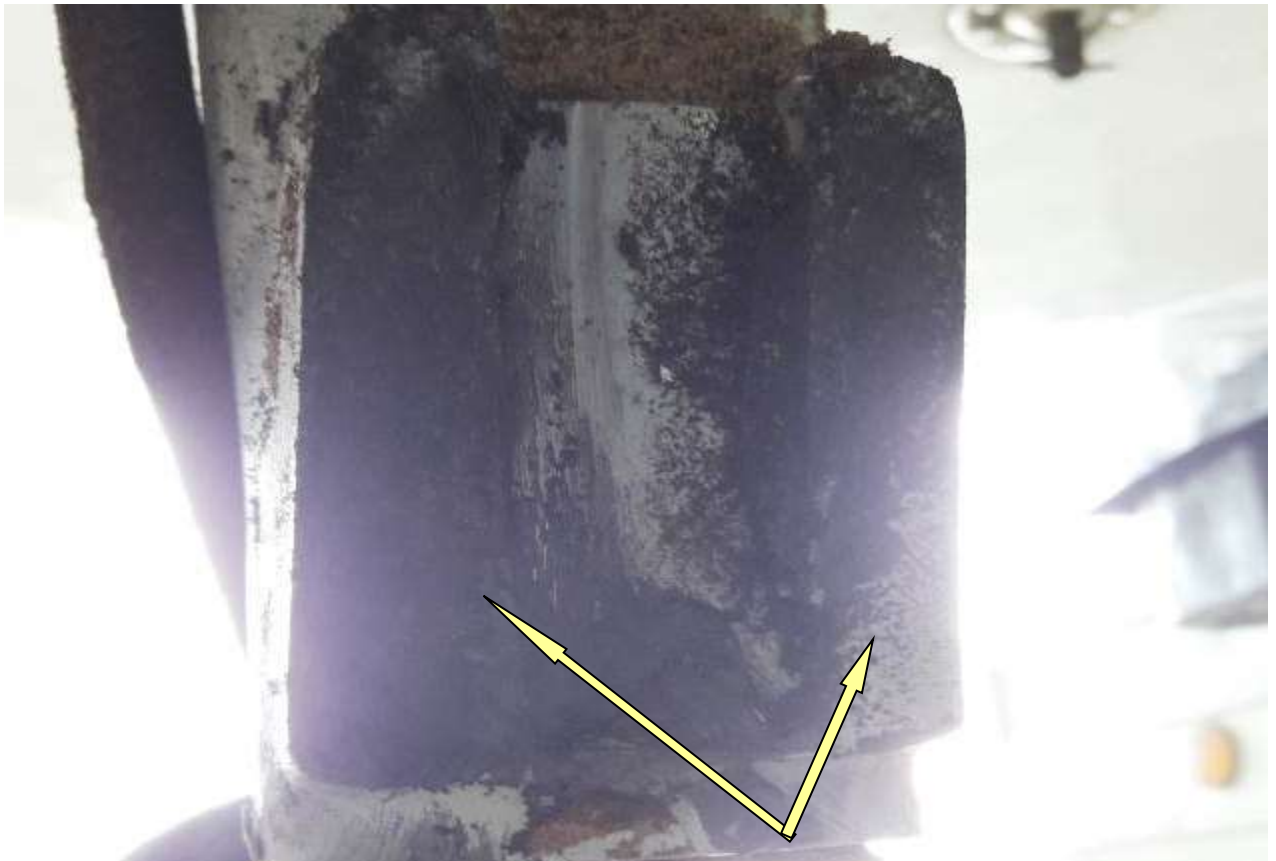
Att. 4. Labās puses šasijas amortizatora cilindra stiprinājumu atloku (auss) lūzuma vietas
