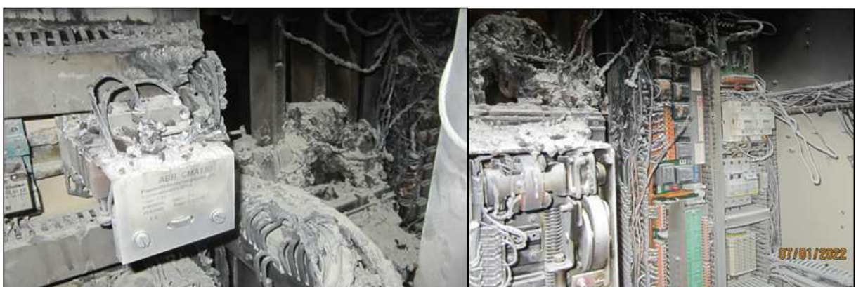
3.att. Sadales panelis pēc ugunsgrēka
