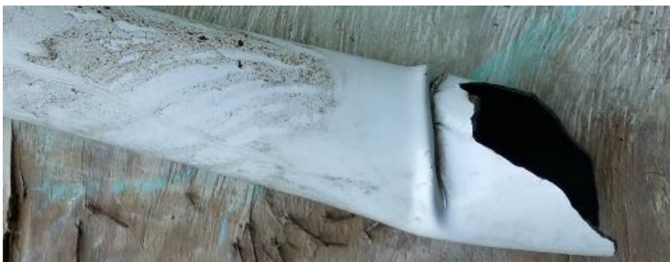
12.att. Priekšējās šasijas balsta augšējā daļa
