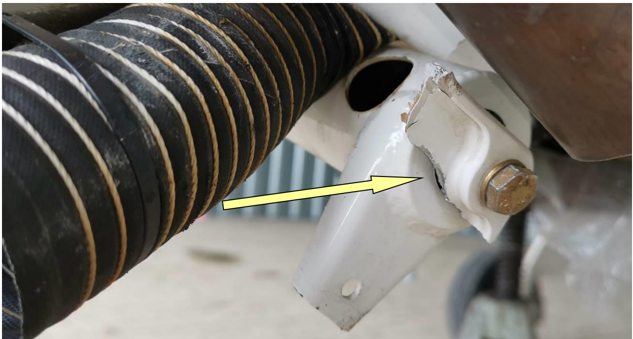
Att. 4. Priekšējās šasijas balsta kreisās puses leņķa atloka lūzums
