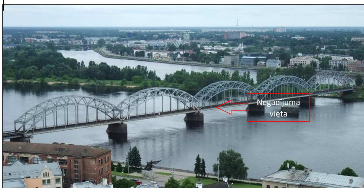
8.3. att. Negadījuma vieta uz tilta
