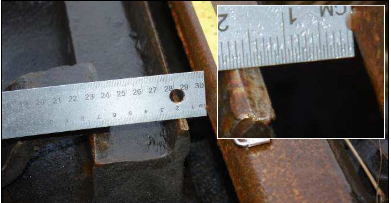
6.14.att. Asmens atiešana no rāmjslīdes pie aizliktņa pacelšanās
