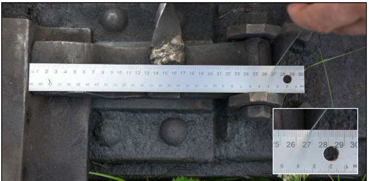
6.8.att. Labā aizliktņa garuma noteikšana
